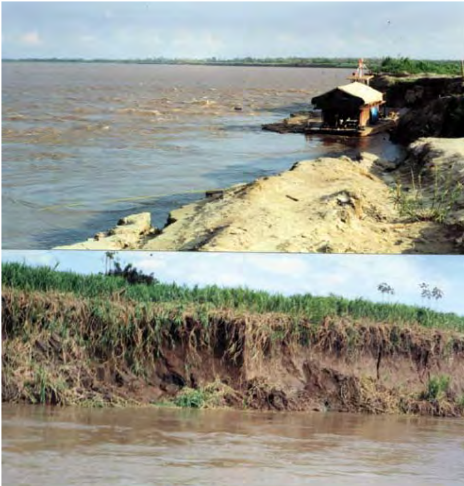
FOTOS 1 y 2. Vemos como el río socava, mediante la corriente Costanera, la terraza del cuaternario aluvial Qh-al2 y la pared lateral de la margen izquierda del cauce del río Ucayali.
