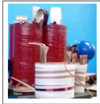
Preparación de los Arrollamientos
